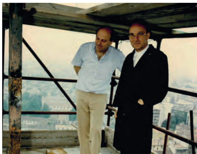
Mons. Gariboldi sulle impalcature del campanile
